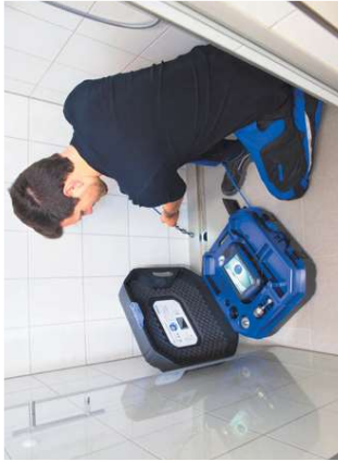
Videoispezione per scarichi loggiani di bagni e cucine.
